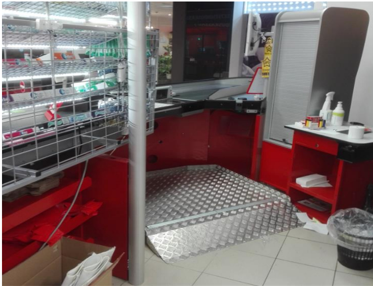
kassasse madala platvormi paigaldamine
